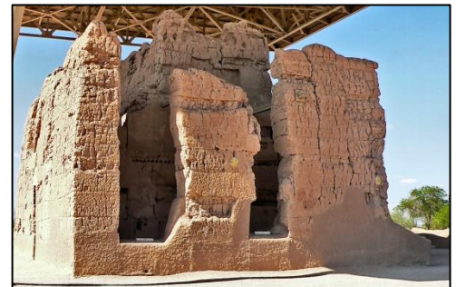
Casa Grande Ruins, Arizona
